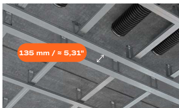
Instalační šířka mezi profily: 135 mm / ≈ 5,31"
